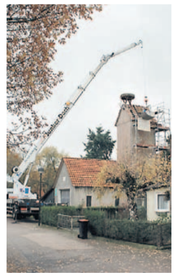
Montage des Nestes auf dem alten Feuerwehrhaus.
