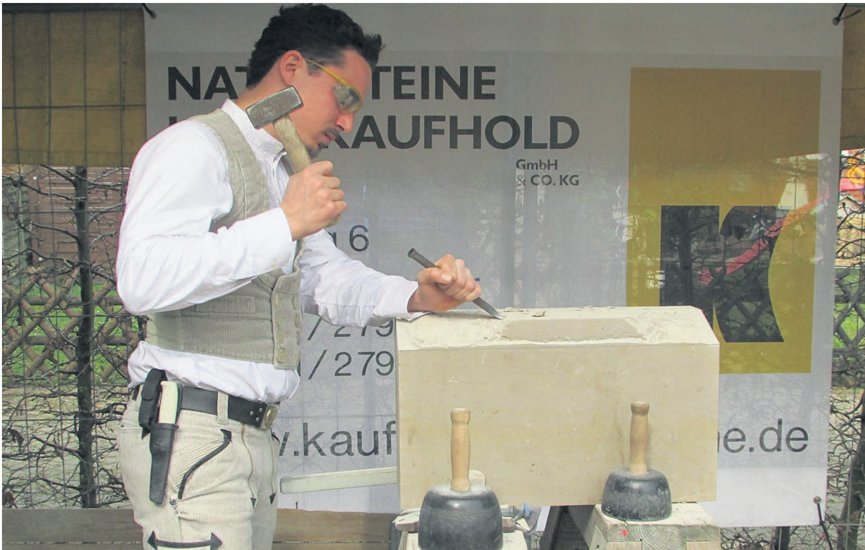
Steinmetz Hauke Bienert bearbeitet auf traditionelle Art und Weise die Oberfläche eines Sandsteinblocks, der ins Gesims eingesetzt wird.
