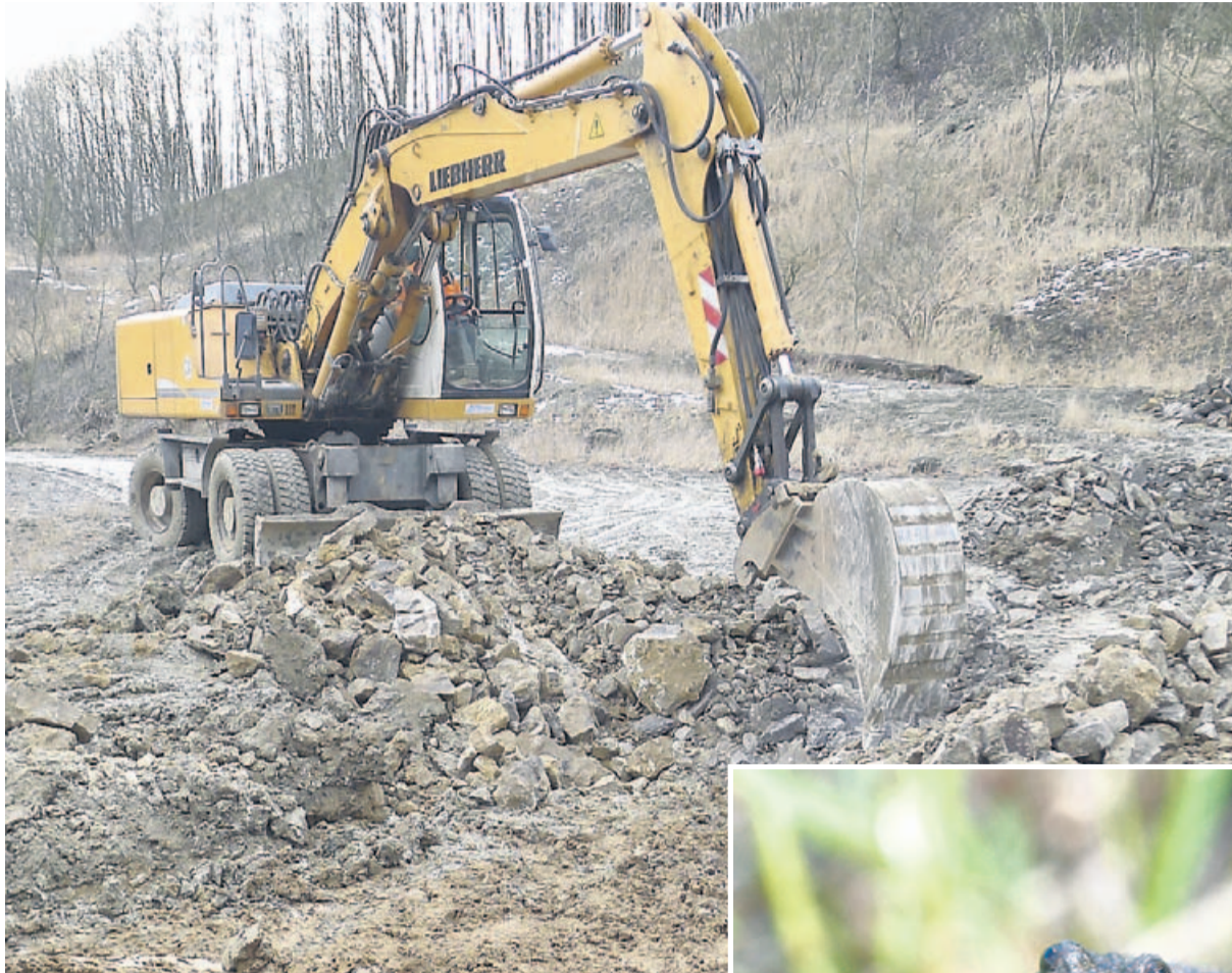
Mit dem Radbagger bearbeiten Projektmitarbeiter den Untergrund in einem Kalksteinbruch, um neuen Lebensraum für die Gelbbauchunke (Bild unten) zu schaffen.
