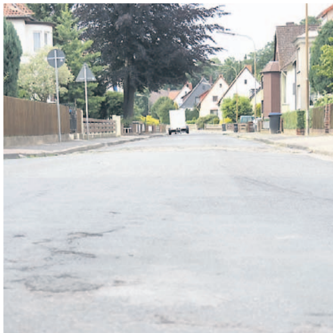
Die Bergstraße in Hessisch Oldendorf ist dieses Jahr für die Oberflächenbehandlung mittels Splitten vorgesehen.
